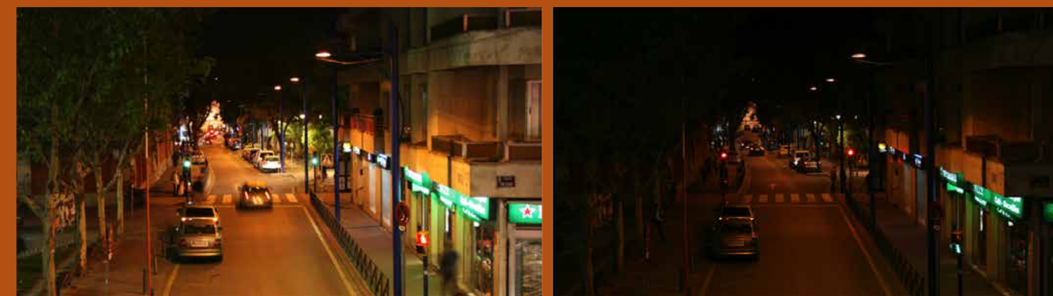
Iluminación de escenas. Regulación de flujo luminoso en una calle. (Fuente: Philips). / Il·luminació d'escenes. Regulació de flux lluminós en un carrer. (Font: Philips)
